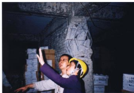
梁、柱爆裂，鋼筋裸露情形
