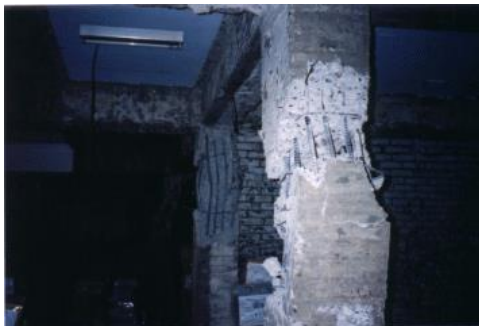
梁、柱爆裂，鋼筋裸露情形
