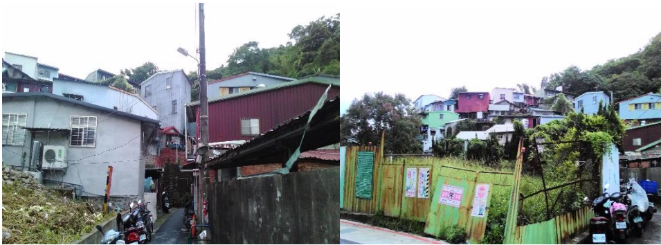
圖 3-3-1 大安區山坡地老舊聚落學府里災點現勘
