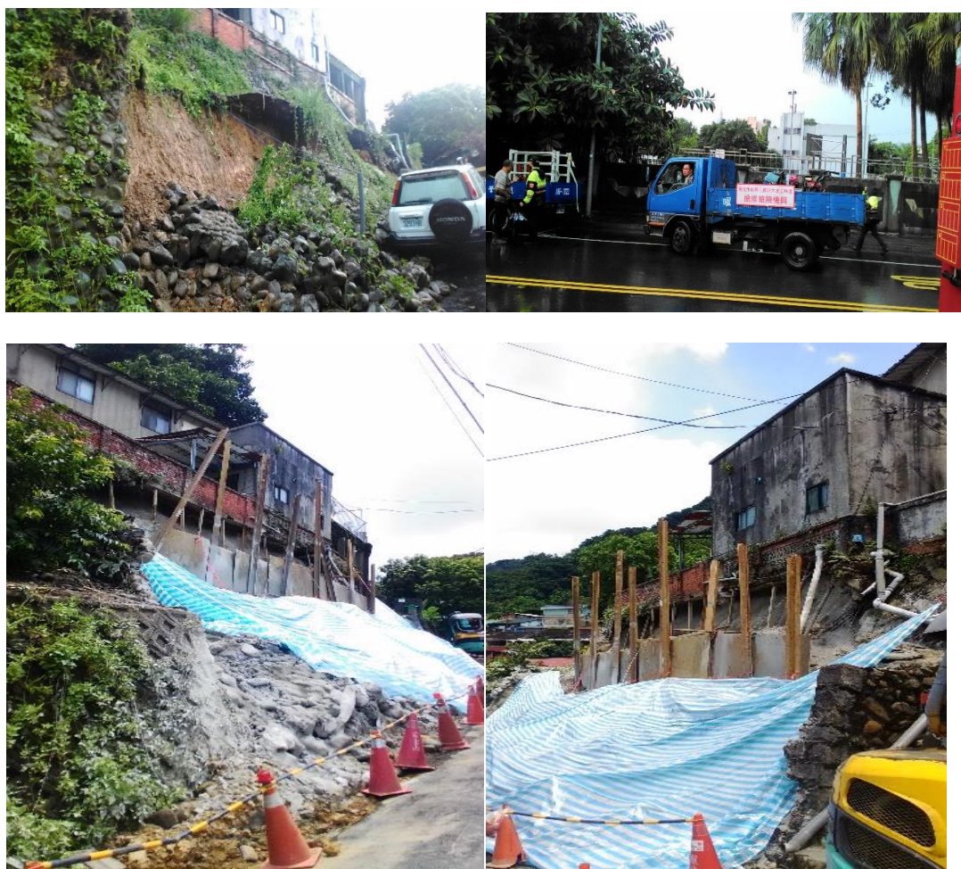
圖 3-3-2105 年 6 月 18 日羅斯福路四段 119 巷 60 弄坍塌事件 資料來源：105 年臺北市災害防救深耕第二期計畫
